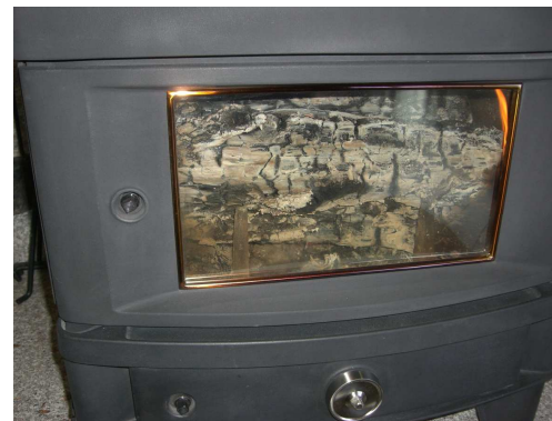
通常運転。 必要に応じて空気を絞る。 通常運転時は、煙が見えない。
