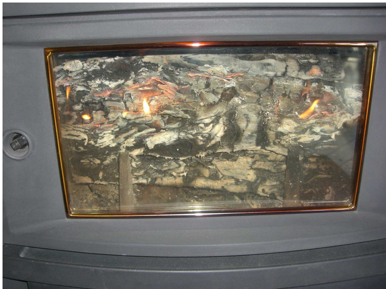
薪全体に火が入ったら、ダンパーを閉める。(焚きつけから25分)
