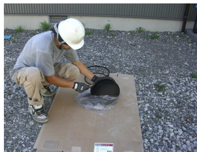
煙突トップを外して、ススの量を計ると40g
