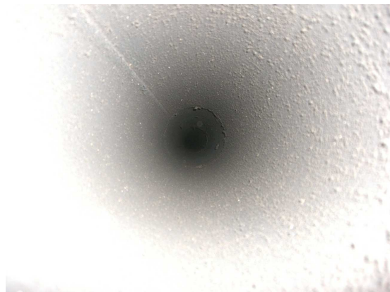
煙突内部(掃除前)
