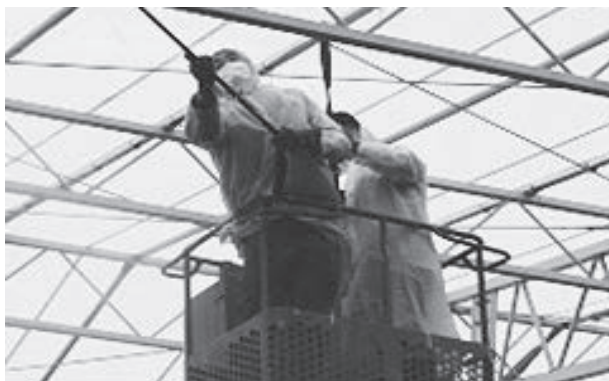
危険をともなう高所作業は資格を取得した社員自身が作業環境を向上させる工夫をしています
